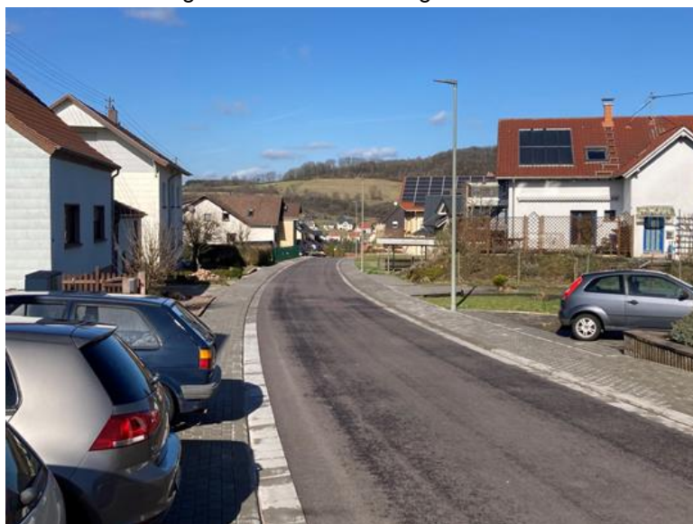
Die fertig sanierte Simmelbergstraße in Limbach
