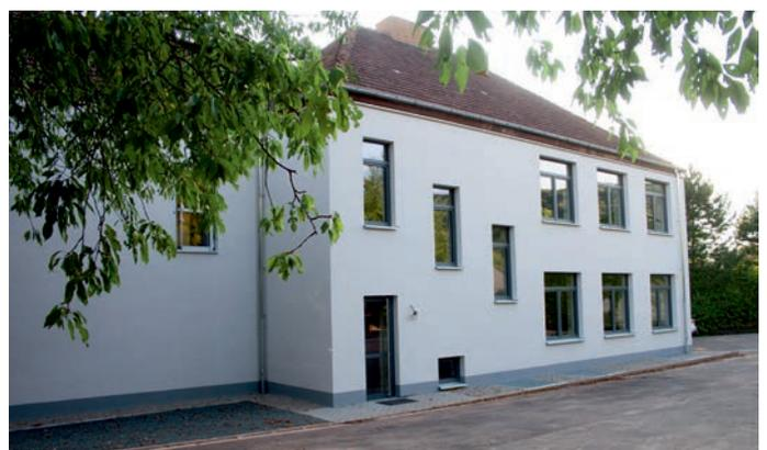
*Die Außenhaut wurde mit einem Wärmedämmverbundsystem gedämmt sowie neue isolierverglaste Fenster eingebaut.*
